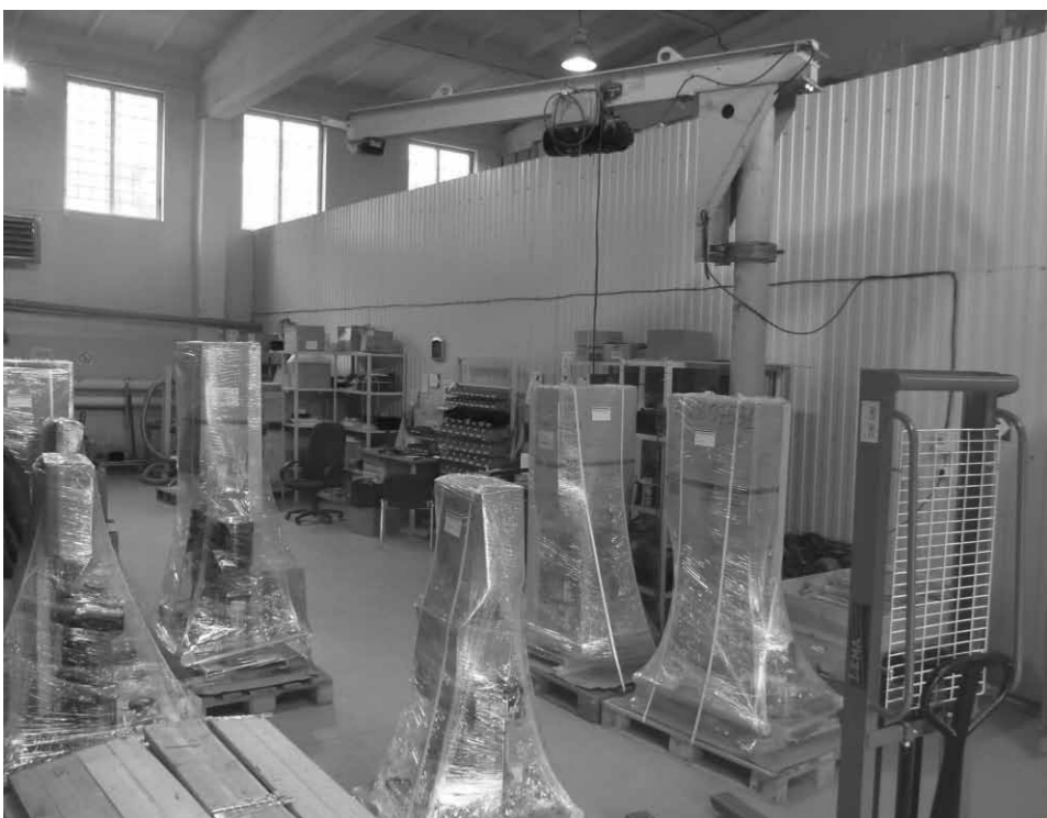
Сборка насосных станций в Екатеринбурге
