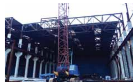
Строительство второй очереди нового цеха электролиза меди для АО «Уралэлектромедь».
