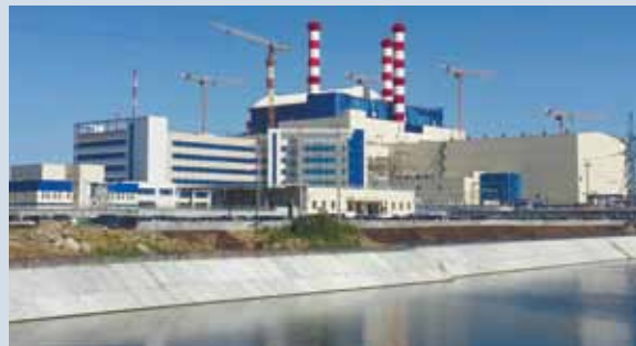
4-й энергоблок БН-800, Белоярская АЭС
