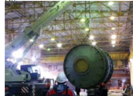
Для филиала «ПСЦМ» АО «УЭМ» в Верх-Нейвинске установлены новые плавильные печи в цехе по производству свинца.
